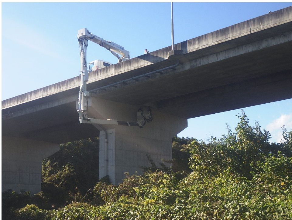
大型点検車を用いた橋梁定期点検(PCRW)
