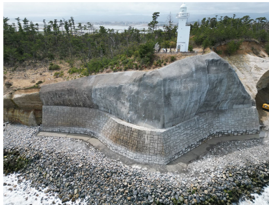
対策施工が完了した法面
