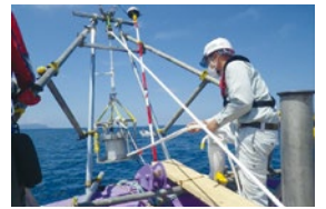
洋上風力発電の最新機材開発(基礎地盤コンサルタンツ)
