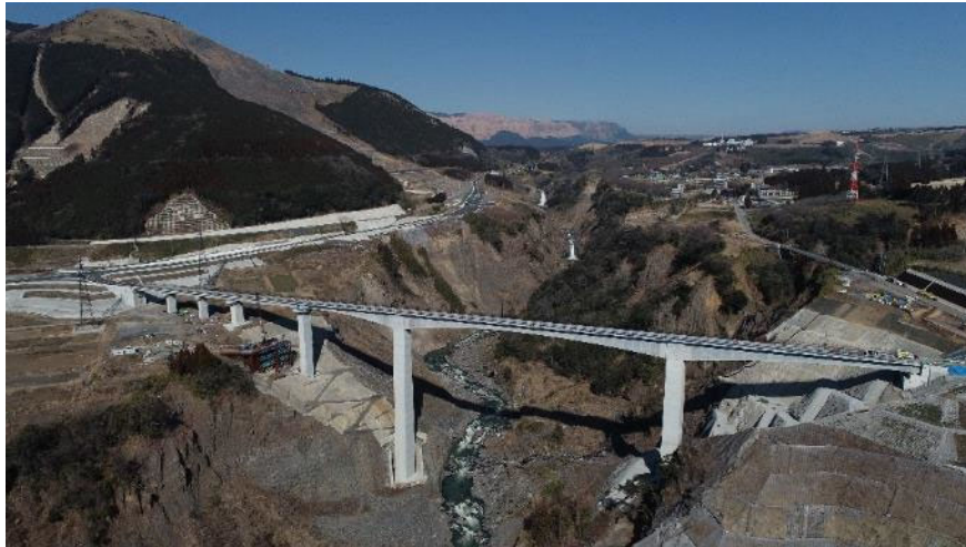
大規模崩壊「数鹿流（すぎる）崩れ」と新阿蘇大橋
