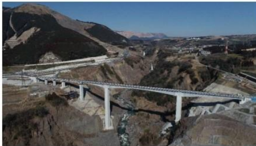
大規模崩壊「数鹿流(すがる)崩れ」と新阿蘇大橋
