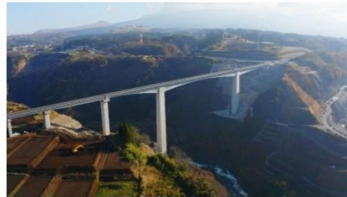
開通した新阿蘇大橋
