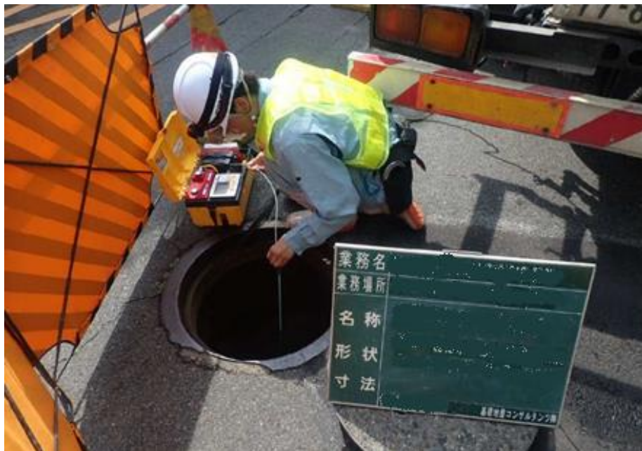
調査前の酸素・硫化水素の濃度測定
