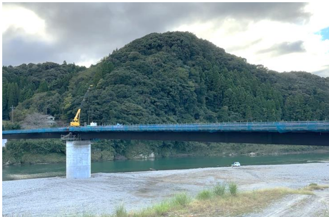
復旧が進められている沖鶴橋
