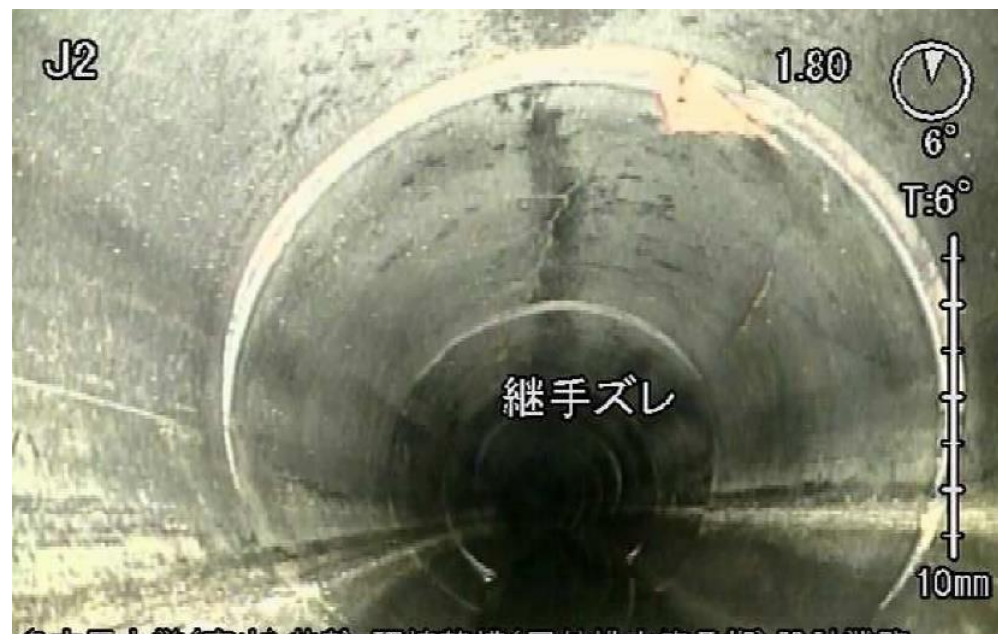
自走式TVカメラによる管内調査
