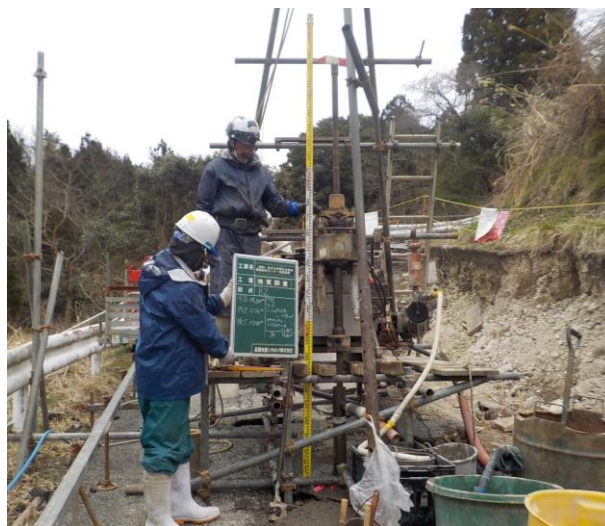
被災地におけるボーリング調査(基礎地盤C)
