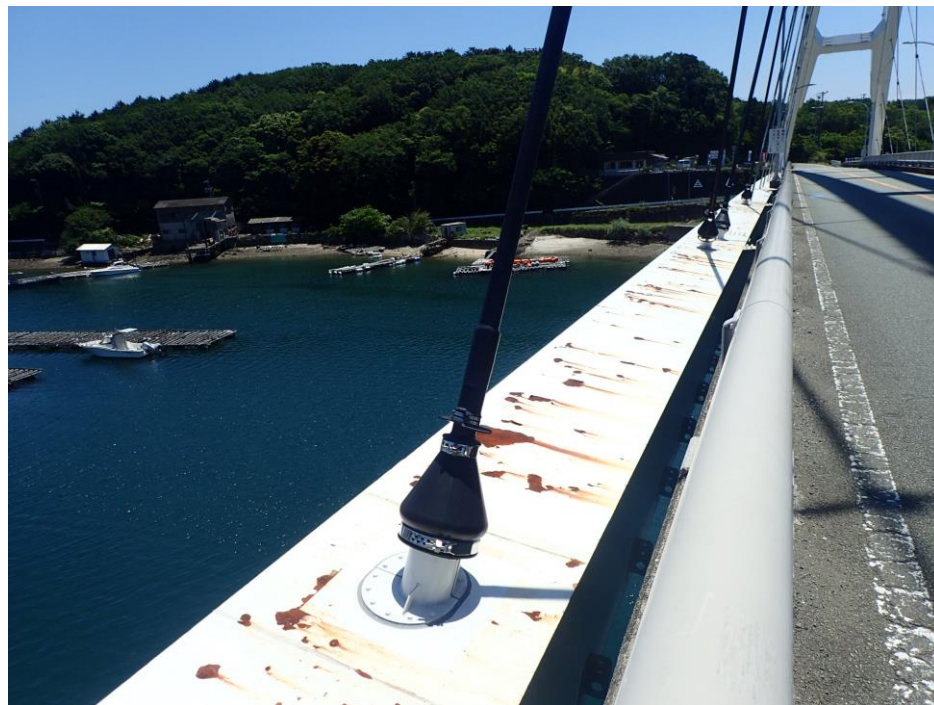
交換工事が完了した吊材
