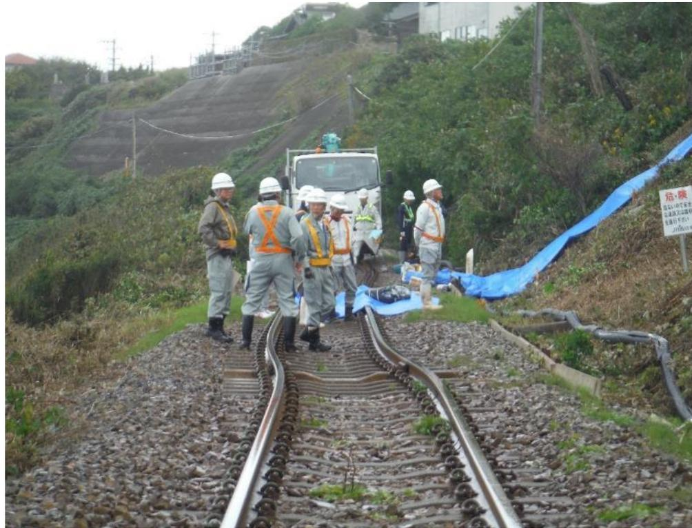
大雨による地すべりで被災した線路を調査(基礎地盤コンサルタンツ)
