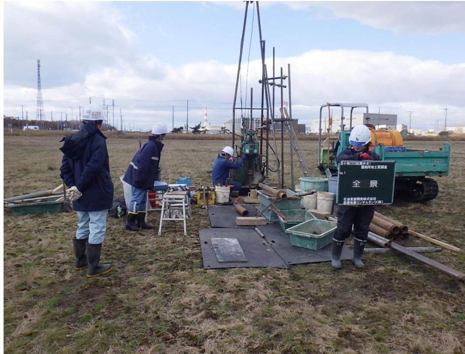
地質的なリスク評価のための土質調査（基礎地盤コンサルタンツ）
