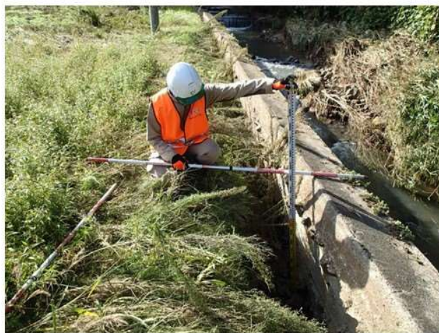
能登半島豪雨の被災箇所対応(長大)
