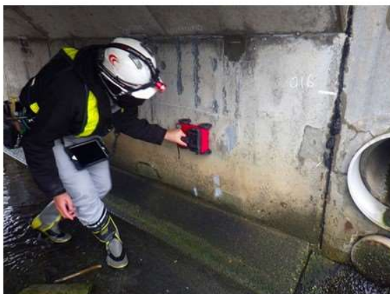
電磁波レーダーを用いたコンクリート構造物内部の点検(長大テック)
