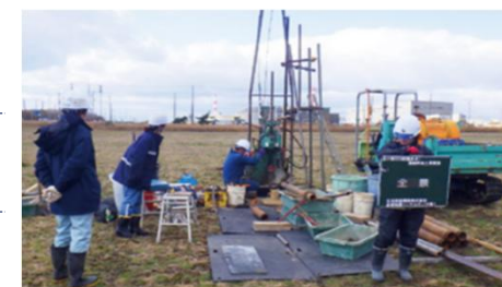
CCS事業 地盤調査
