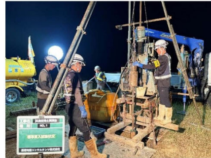
土質調査(標準貫入試験)
