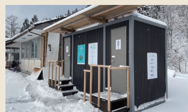
能登町の避難所に設置したA.Qトイレ
