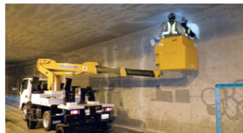
高所作業車で地下道を点検
