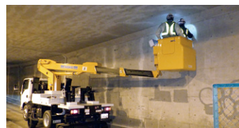
高所作業車で地下道を点検
