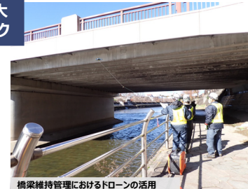
橋梁維持管理におけるドローンの活用
