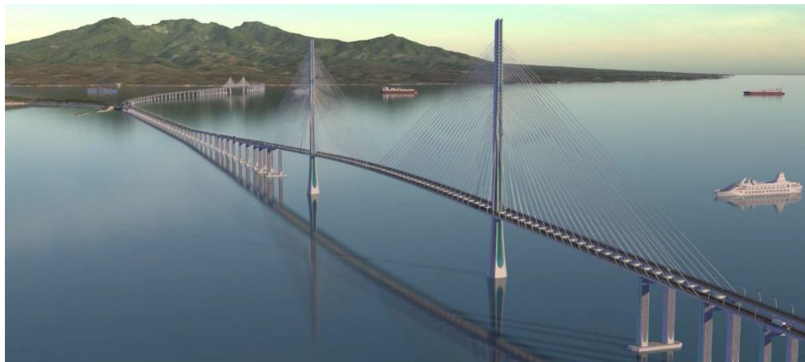
バターン-カビテ連絡橋架橋の完成イメージ
