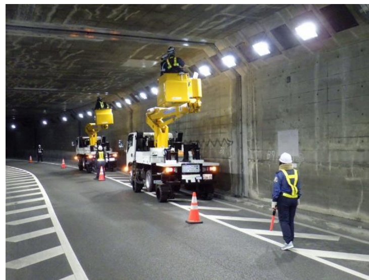
高所作業車で地下道を点検
