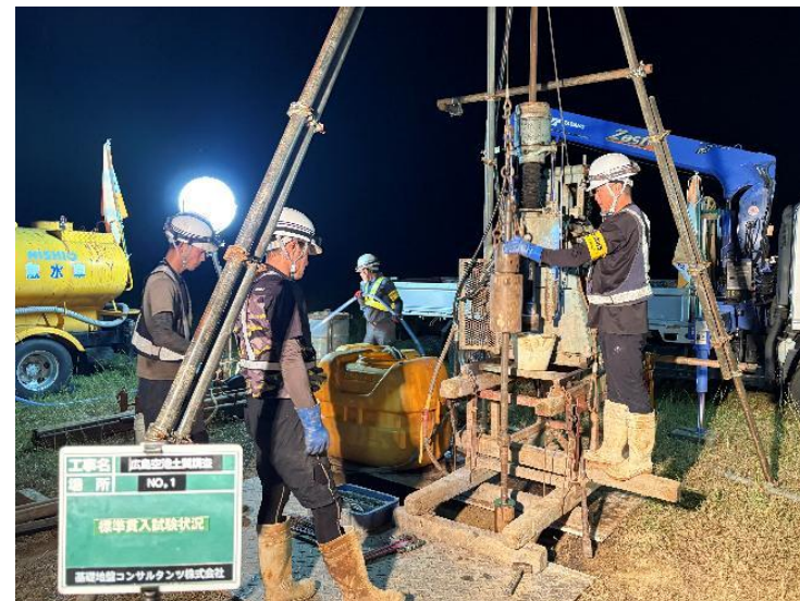
土質調査(標準貫入試験)
