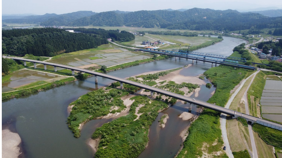
災害時の代替路線として開通した最上川大橋
