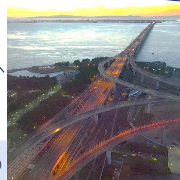
関西国際空港連絡橋 1994年4月開通 平成3年度土木学会田中賞(作品部門)
