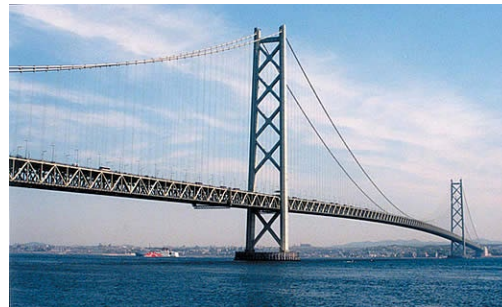
明石海峡大橋 1998年4月開通 平成9年度土木学会田中賞受賞
