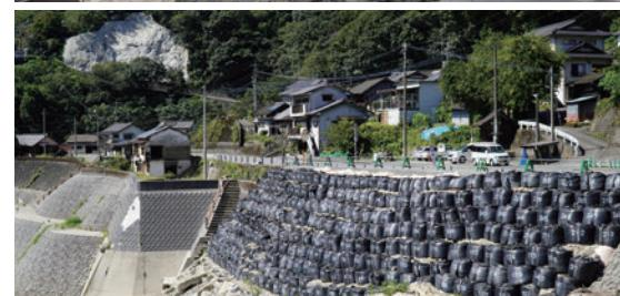
長大は7月7日、国道219号の被災状況を確認。球磨川の本流に沿った低地に広がる住宅地では、建物の多くが原型をとどめずに破壊され、瓦礫が押し流されました。また、国道沿いでは、電柱が傾き、電線には漂流物が付着していました。橋梁は、橋台、橋脚を残して上部構造が流され河川内に転落しているものもありました。
