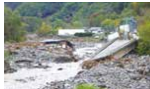
緊急迂回路、右側に施工中の仮橋
