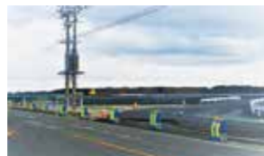
仮橋の施工状況
