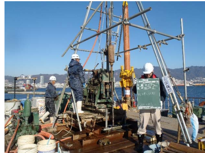
海上ボーリング調査
