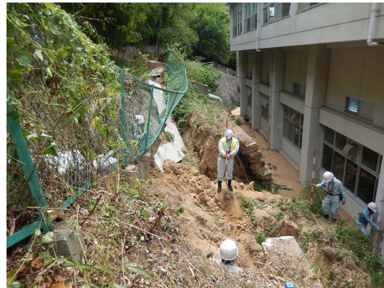
崩壊した斜面の測量
