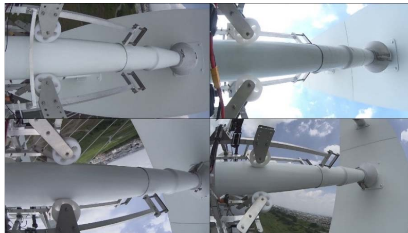
「VESPINAE」が撮影した斜張橋ケーブル
