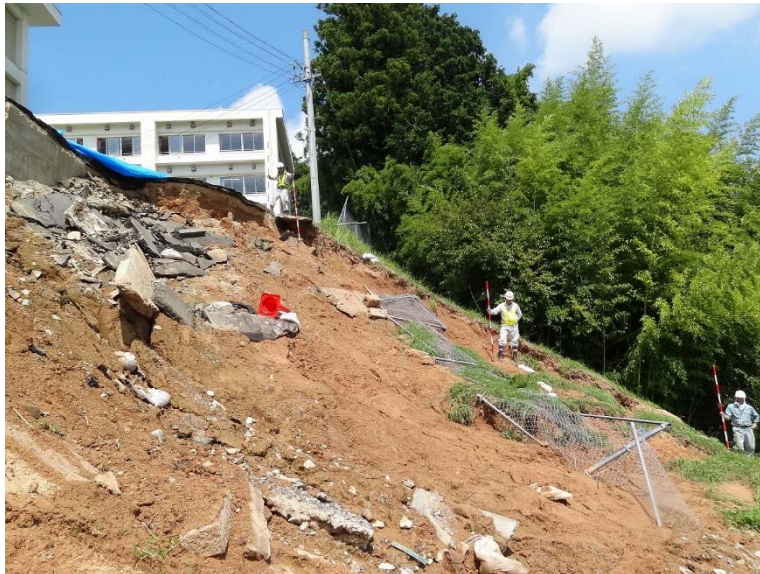
崩壊した斜面の測量
