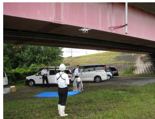
ドローンによる橋梁点検
