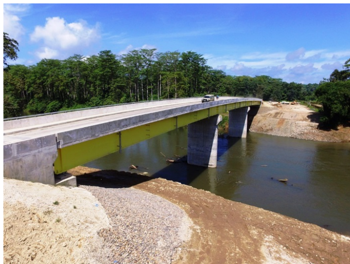
開通したカピウラ橋（大日本土木株式会社提供）
