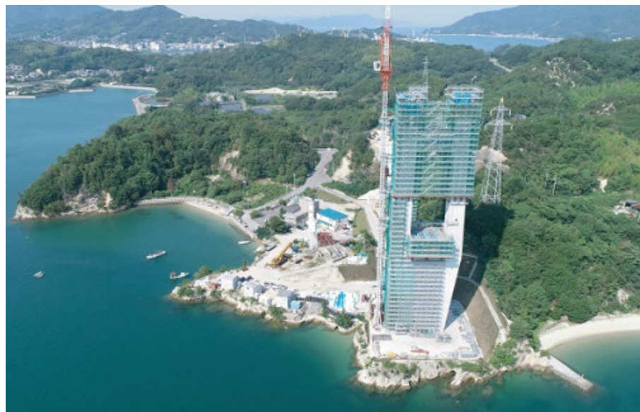
建設中の岩城橋
