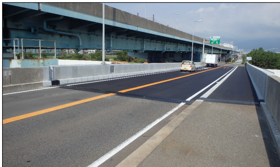
1年後に開通した鳴尾橋
