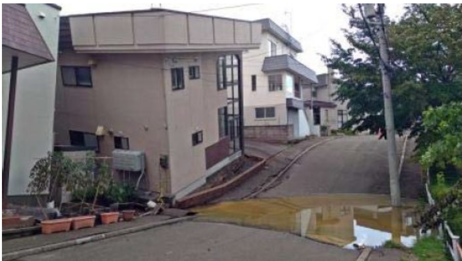
北海道胆振東部地震により崩壊した宅地
