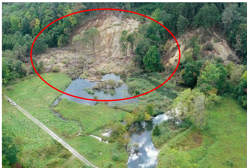
斜面崩壊による河川閉塞（ドローン空撮）
