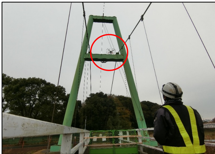
ドローンによる高所の点検
