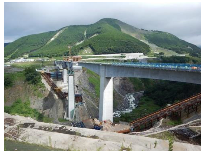
復興工事中の阿蘇大橋
