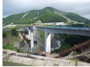
復興工事中の阿蘇大橋
