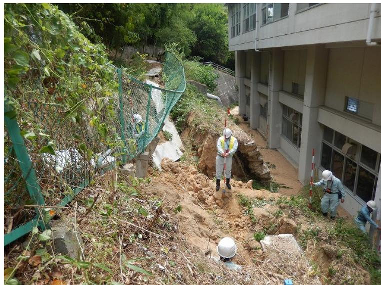
崩壊した斜面の測量
