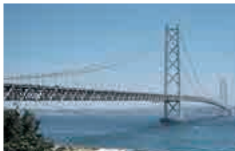
明石海峡大橋(兵庫県)
