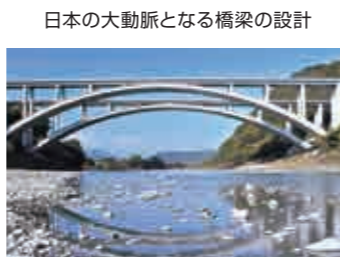
新東名高速道路 富士川橋(静岡県)
