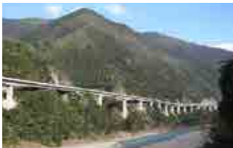
七色高架橋(奈良県)
