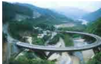
西沢大橋(山梨県)
