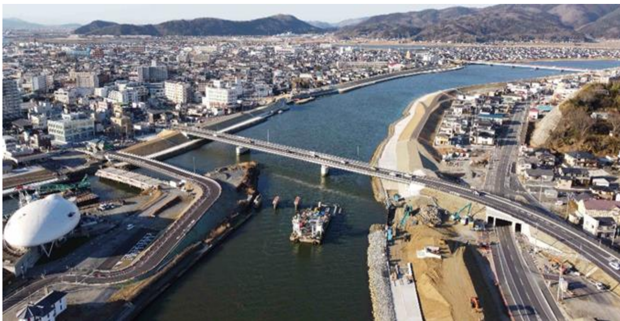
石巻市 内海橋
