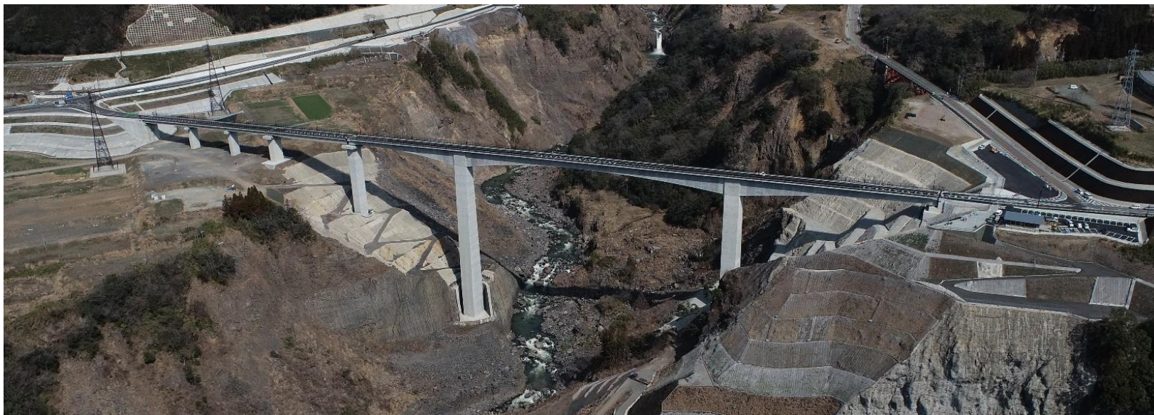
開通した新阿蘇大橋
